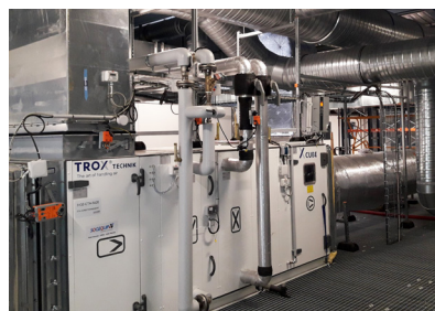
Traitement d'air et dépeussierage d'un nouvel atelier de cosmétique blanche
