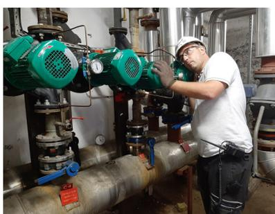
Désembouage du réseau hydraulique d'un lycée rhônalpin avec notre équipe dédiée au traitement d'eau SOGEWATER
